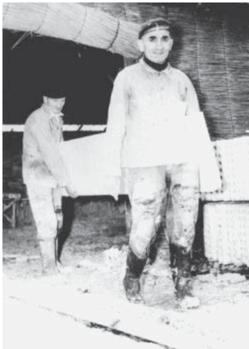
Atelier de préfabrication du chantier de La Peupleraie à Fresnes (1955-1962)
