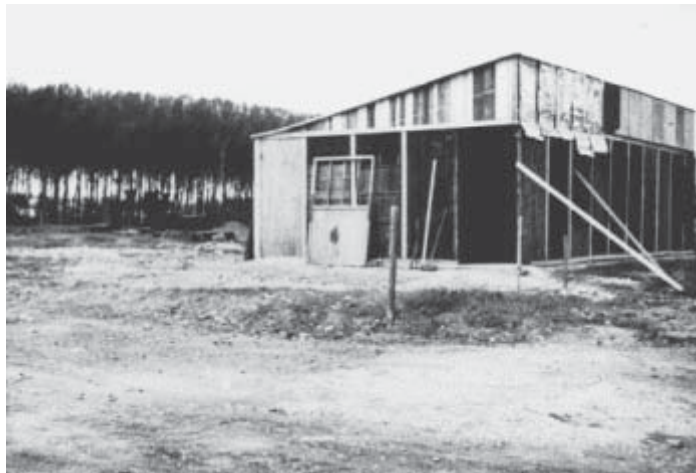
Atelier de préfabrication du chantier de La Peupleraie à Fresnes (1955-1962)
